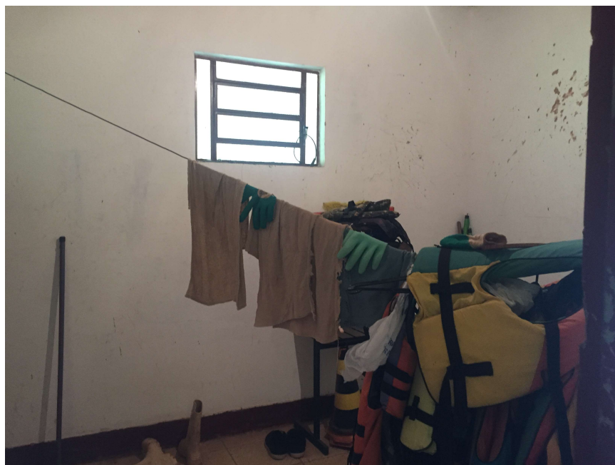
Foto 29 – Sala utilizada como depósito
