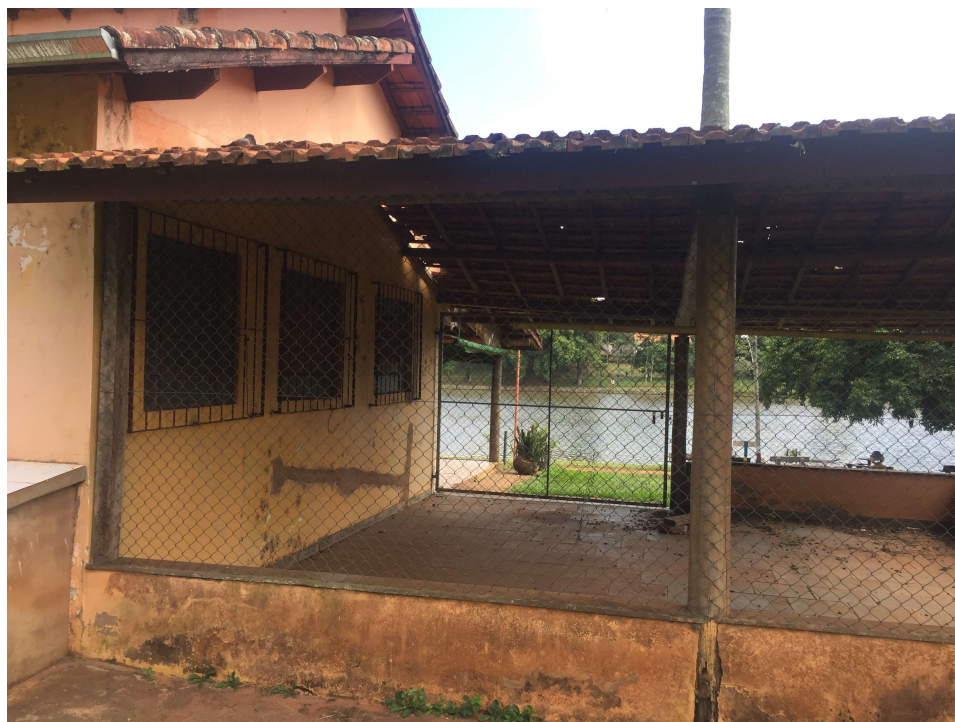
Foto 3 – Lateral direita cercada por alambrado (vista posterior)
