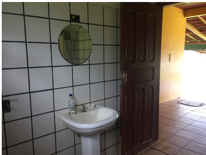
Foto 15 – Lavatório e espelho do banheiro feminino
