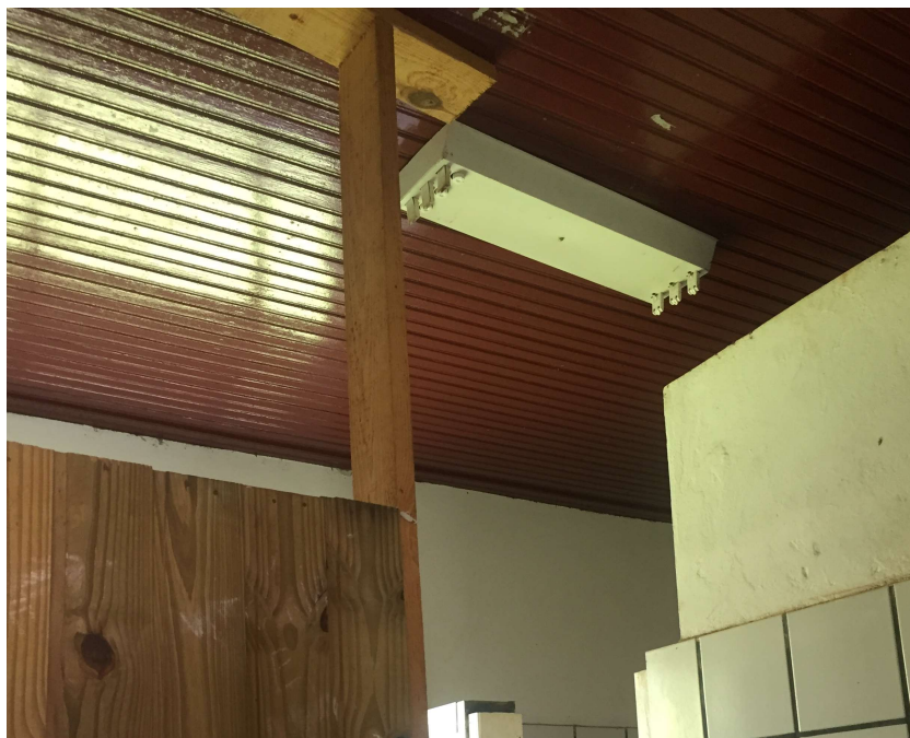
Foto 20 – Luminária e divisória criada no banheiro masculino
