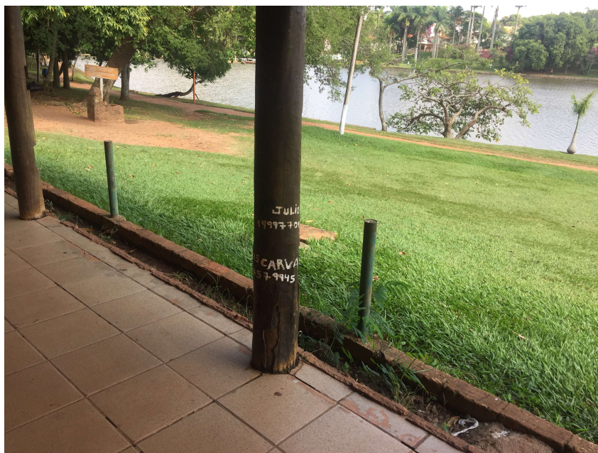
Foto 10 – Detalhes da canaleta de coleta de águas pluviais
