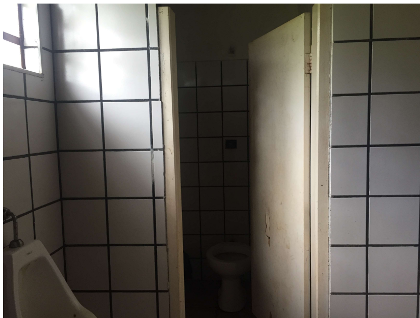
Foto 19 – Box do banheiro masculino
