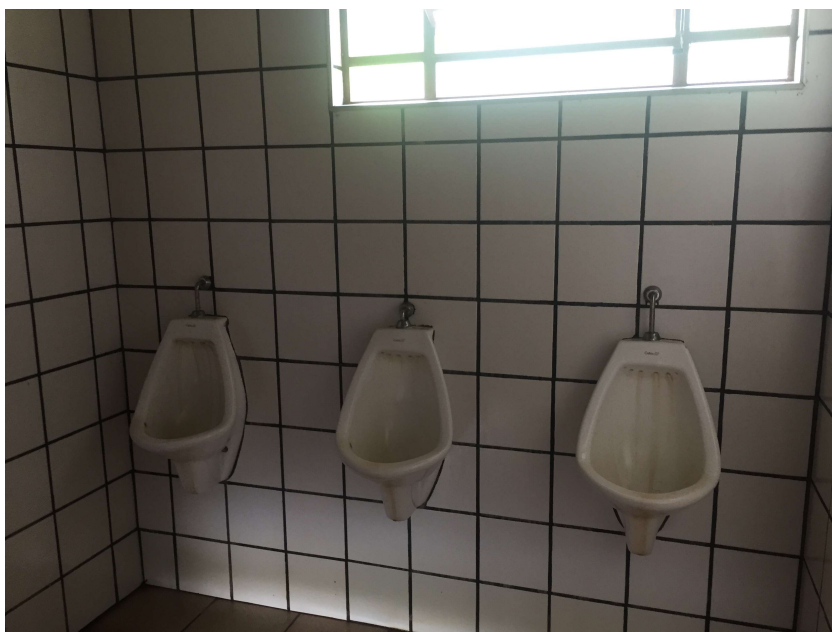
Foto 17 – Mictórios do banheiro masculino
