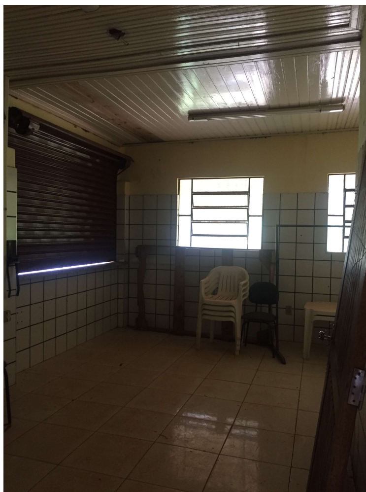
Foto 25 – Janelas basculantes da cozinha da lanchonete
