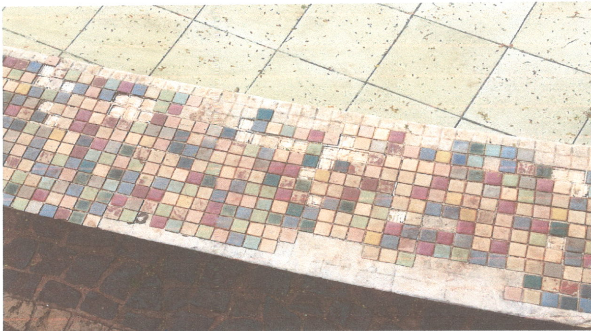
Restauração, recomposição e limpeza das pastilhas originais coloridas de 2,5 x 2,5 cm comprometidas
