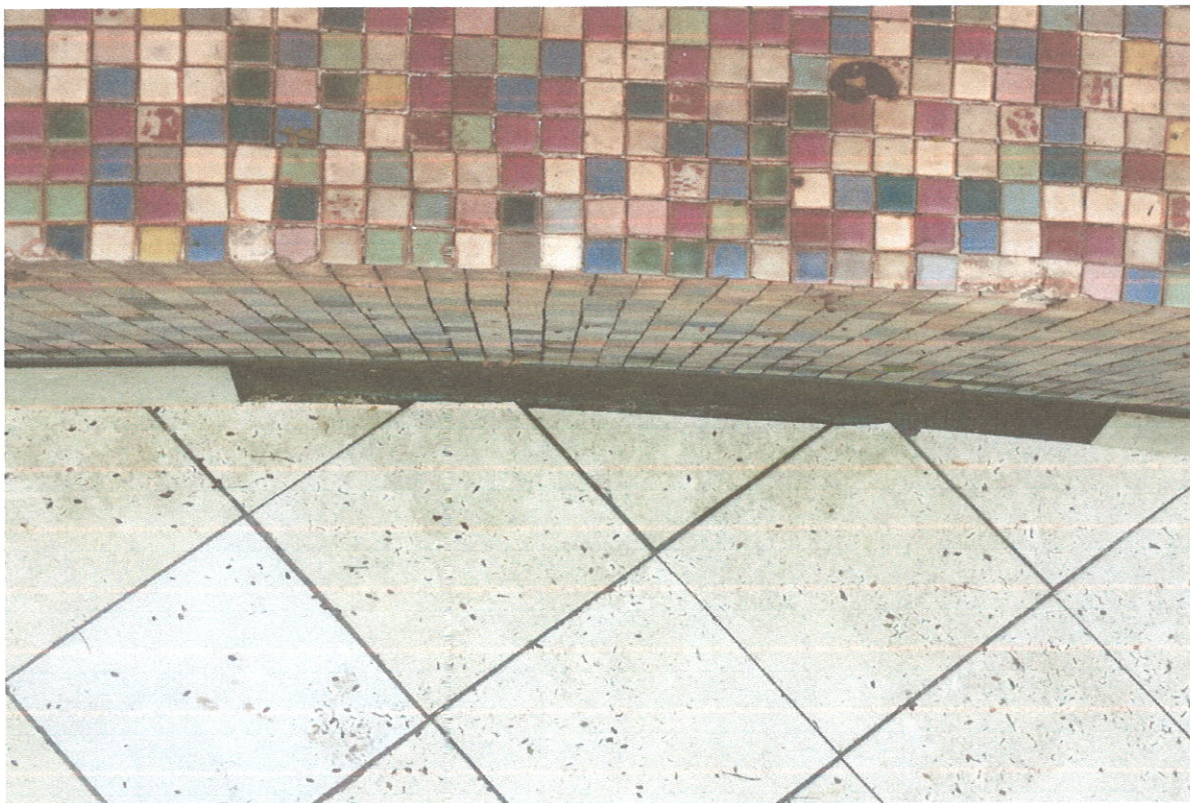
Restauração, recomposição e limpeza das pastilhas originais coloridas de 2,5 x 2,5 cm comprometidas
