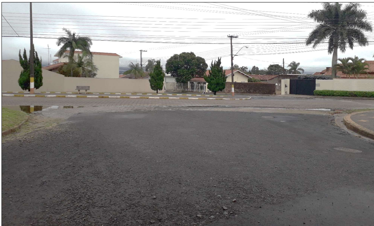
Foto 10. Situação atual da via na Rua Letônia.
