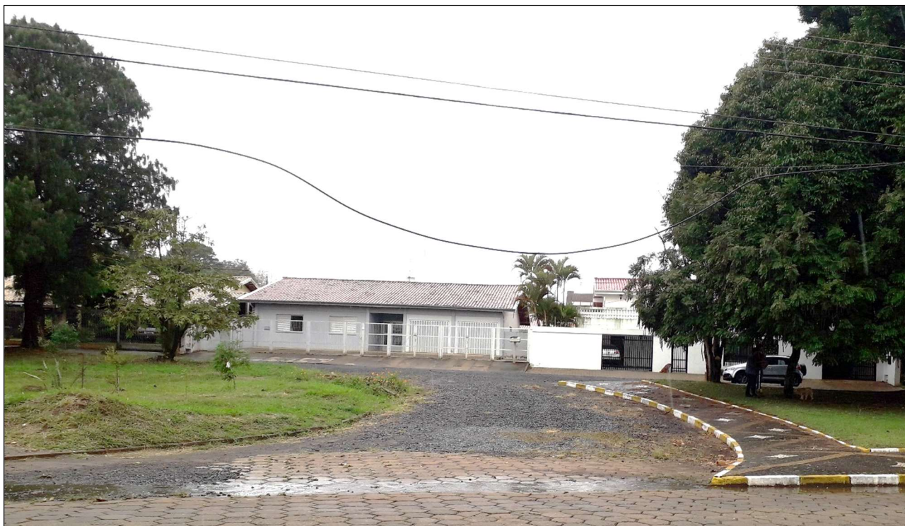
Foto 24. Situação atual da via na Rua Letônia.
