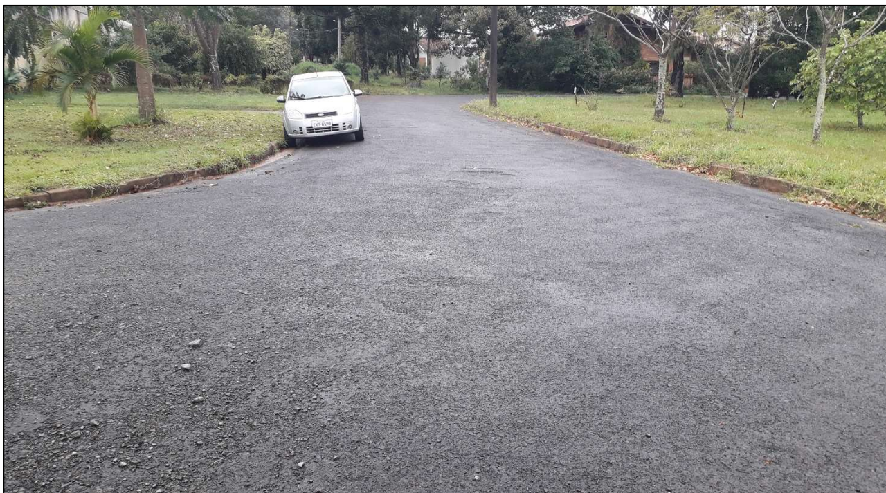
Foto 12. Situação atual da via na Rua Letônia.
