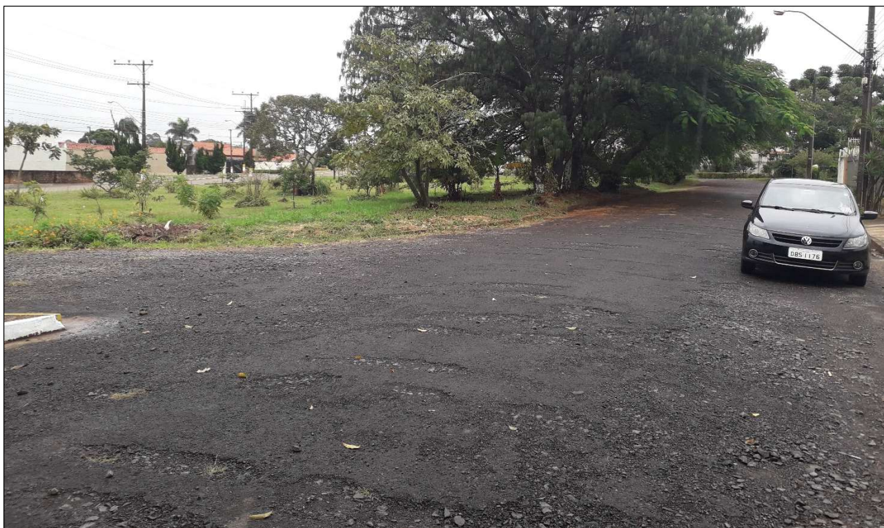
Foto 21. Situação atual da via na Rua Letônia.
