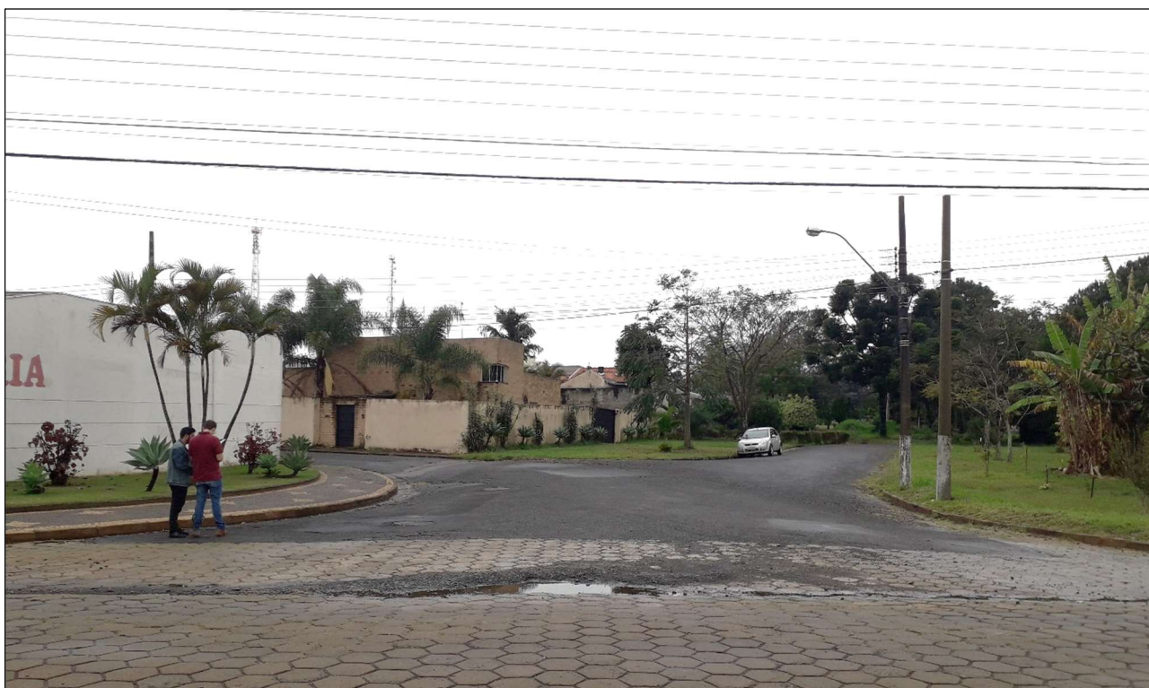
Foto 9. Situação atual da via na Rua Letônia.
