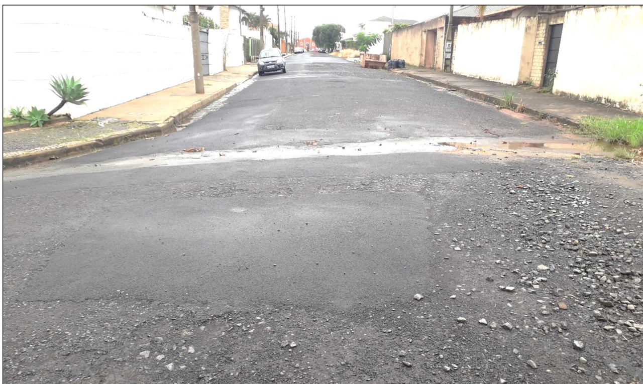
Foto 11. Situação atual da via na Rua Letônia.
