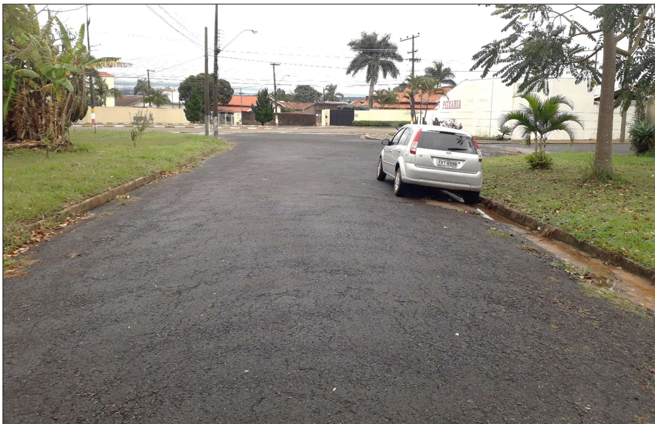
Foto 13. Situação atual da via na Rua Letônia.
