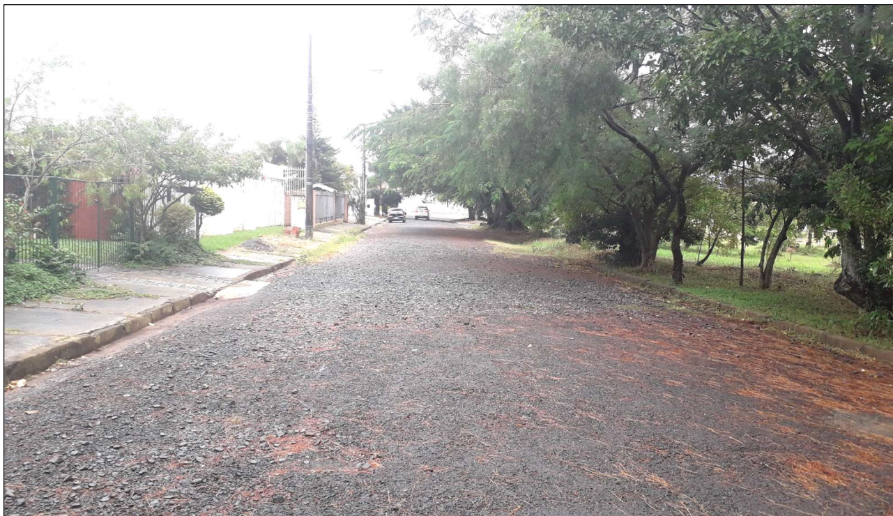
Foto 16. Situação atual da via na Rua Letônia.
