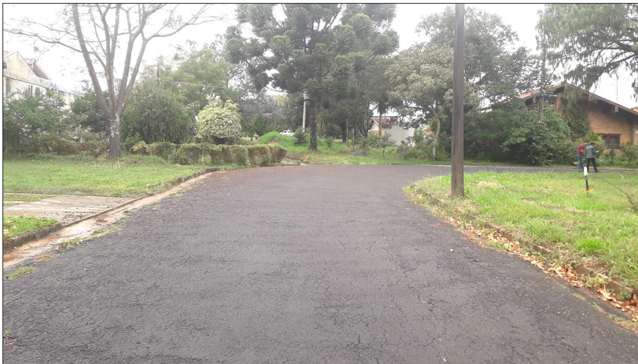
Foto 14. Situação atual da via na Rua Letônia.
