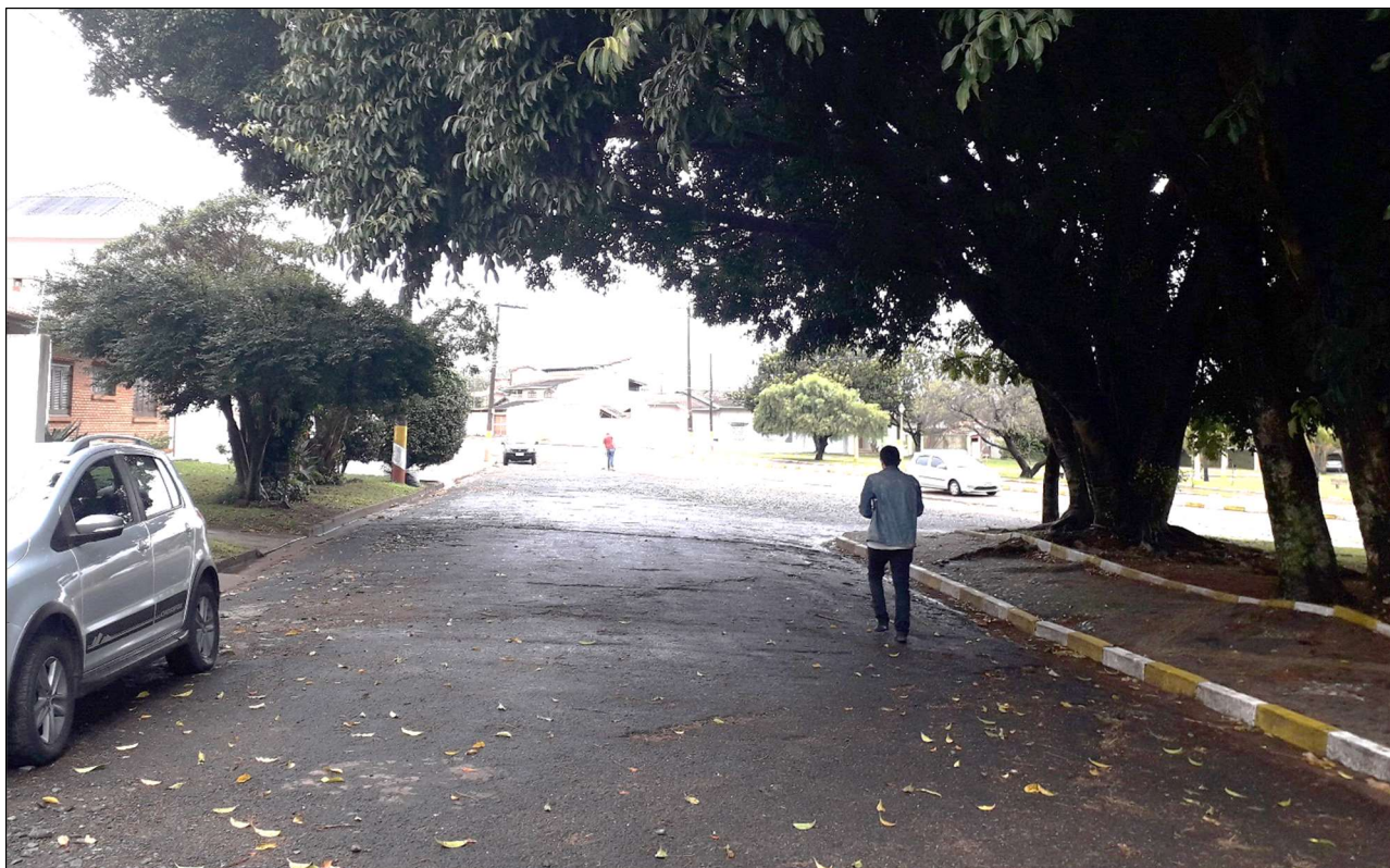
Foto 22. Situação atual da via na Rua Letônia.
