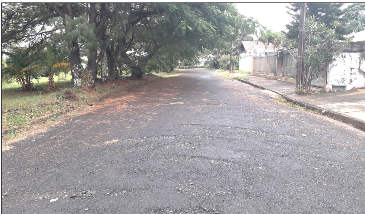
Foto 17. Situação atual da via na Rua Letônia.
