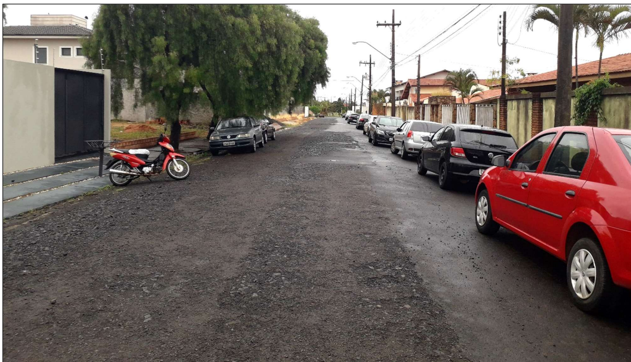
Foto 3. Situação atual da via na Rua Finlândia.
