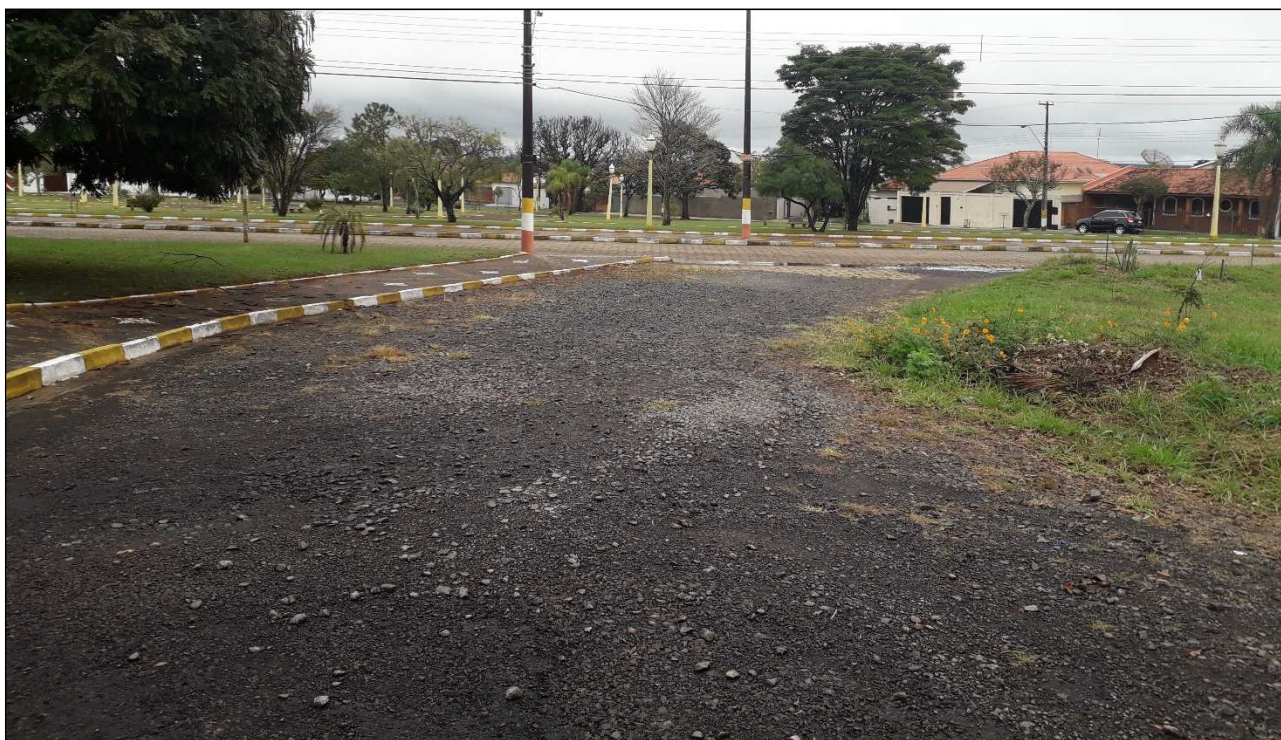
Foto 19. Situação atual da via na Rua Letônia.
