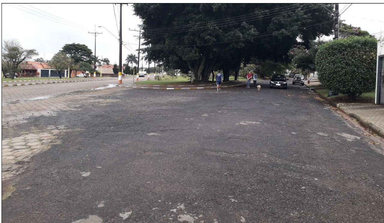
Foto 23. Situação atual da via na Rua Letônia.
