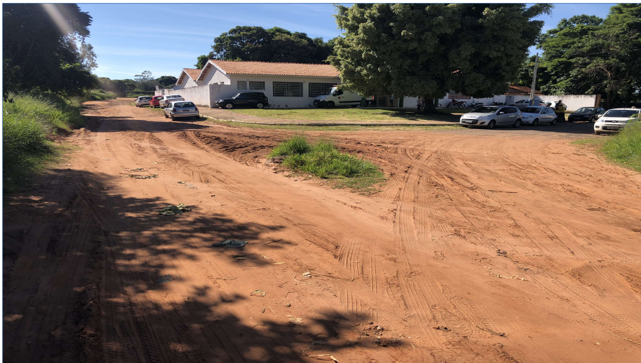
Foto 6. Rua Abraham Dabus esquina com Rua Manoel Amaral.
