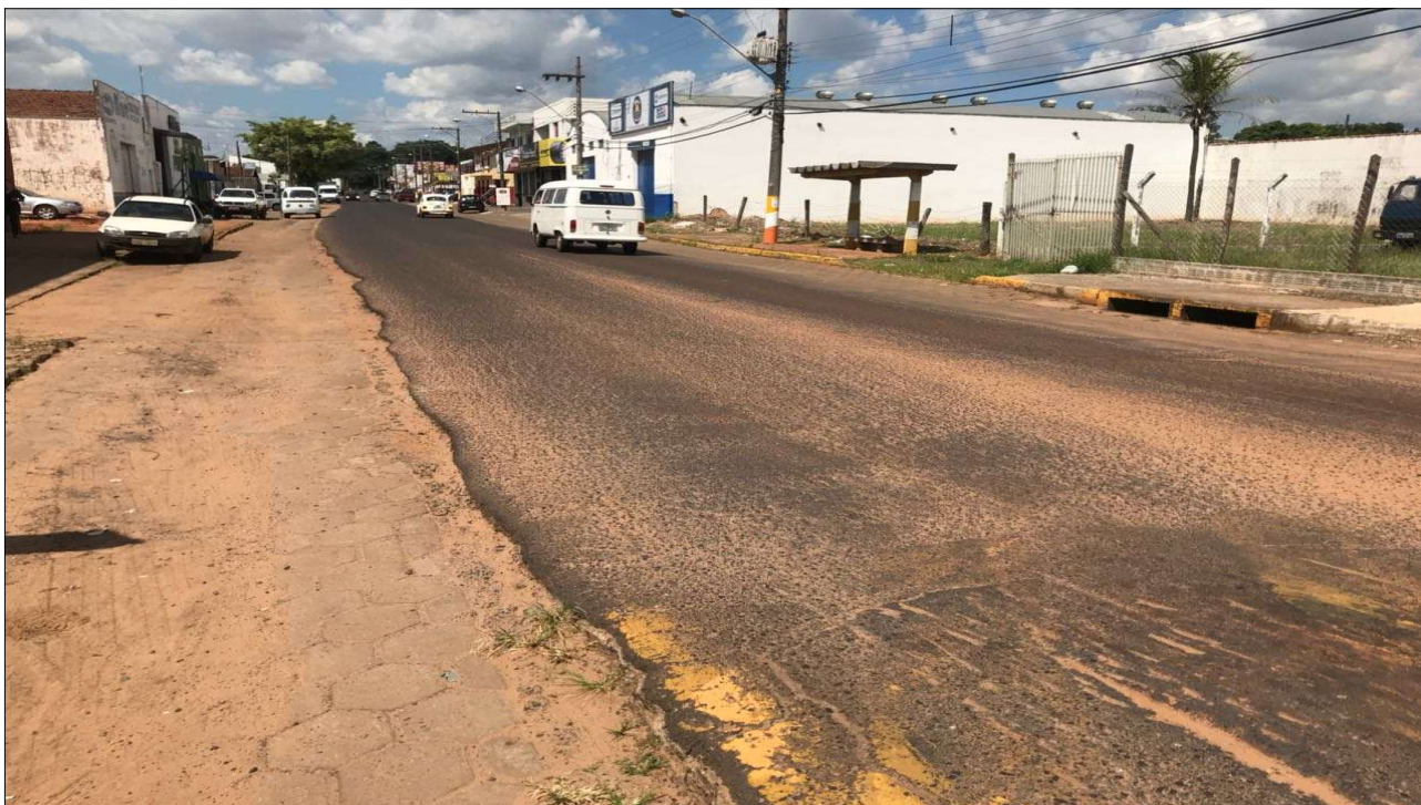
Foto 3. Situação atual da via na Av. Anápolis.
