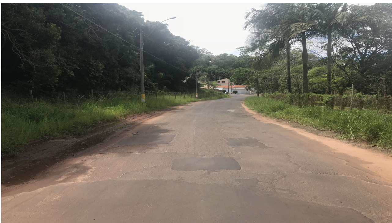
Foto 15. Situação atual da via na Rua Francisco Cruz.
