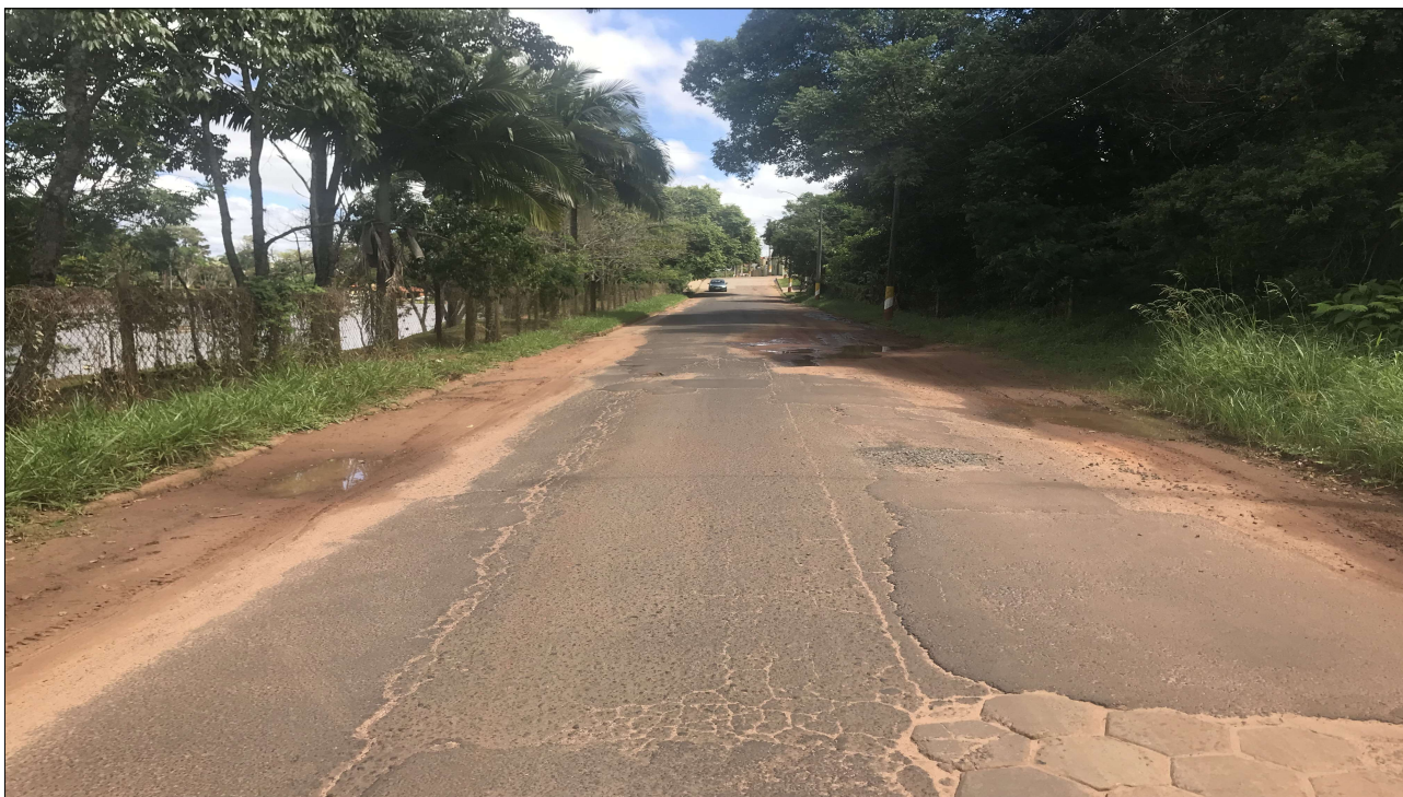
Foto 14. Situação atual da via na Rua Francisco Cruz.
