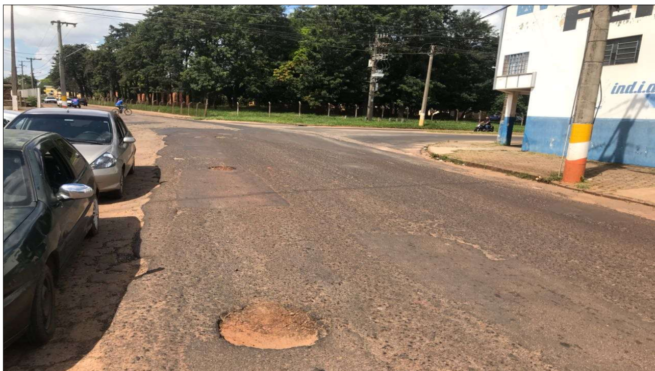
Foto 1. Situação atual da Av. Anápolis.
