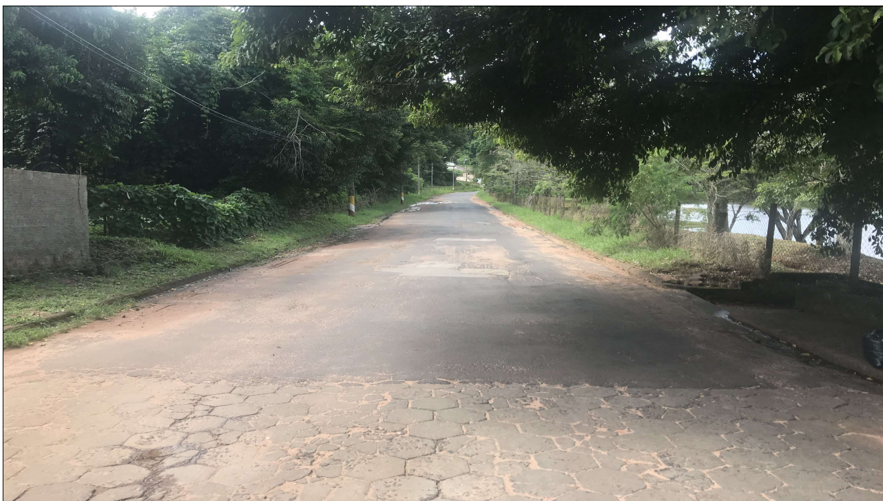
Foto 13. Situação atual da via na Rua Francisco Cruz.
