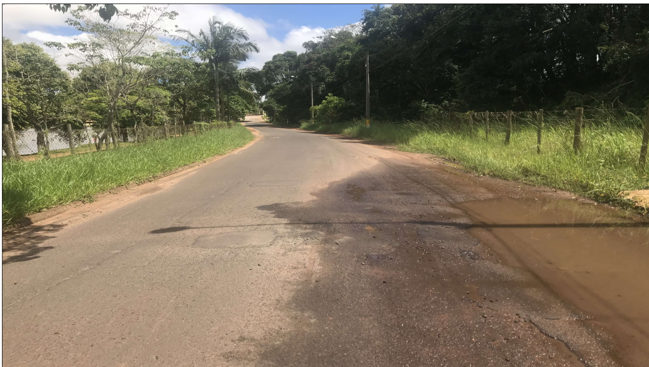
Foto 16. Situação atual da via na Rua Francisco Cruz.
