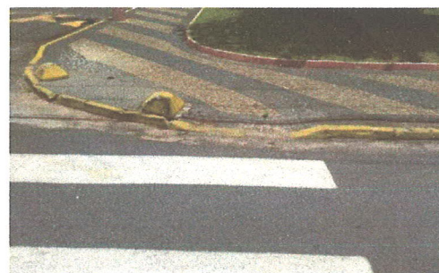
Figura 17. Esq. R. Pará - R. Domiciano Santana.
