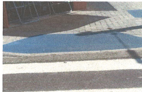
Figura 42. Esq. R. Pará - R. Santa Catarina.
