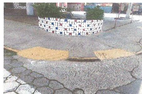
Figura 40. Esq. R. Pará - R. Santa Catarina.
