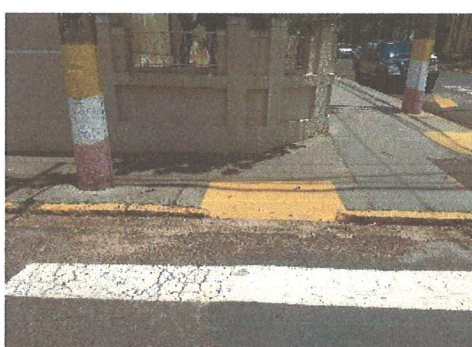
Figura 14. Esq. R. Pará - R. Domiciano Santana.
